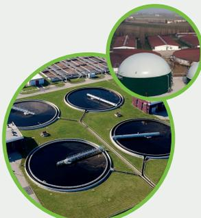
DEPURADORAS DE AGUA CON DIGESTIÓN ANAEROBIA
